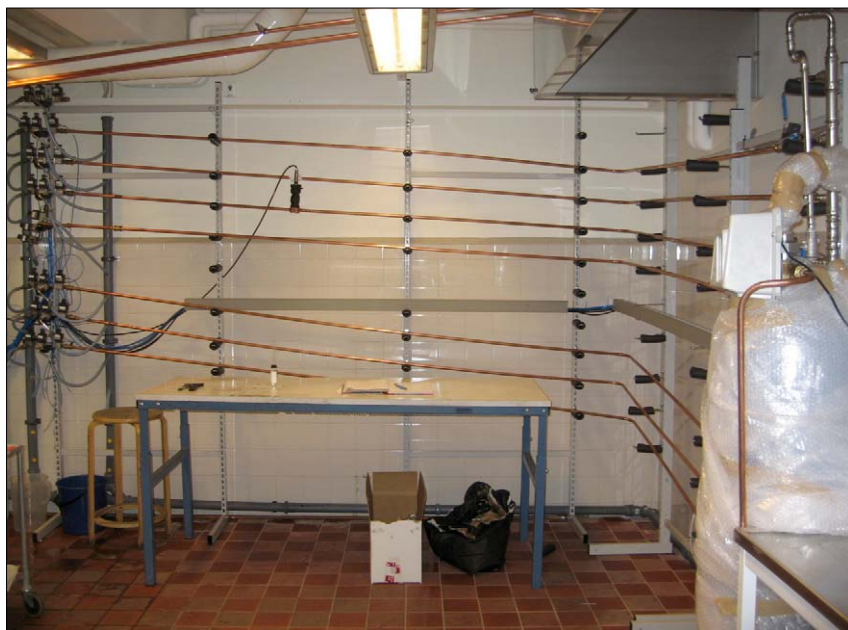
Figur 2-1 Bild på riggprovningsen som används för försöken. Det isolerade filtret syns till höger i bilden.
